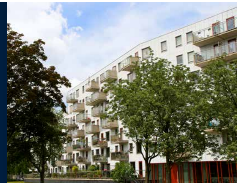
Nieuw Bleyenburg in Utrecht, een van de VvE Metea-complexen waar Van den Pol al jarenlang werkzaamheden uitvoert.
