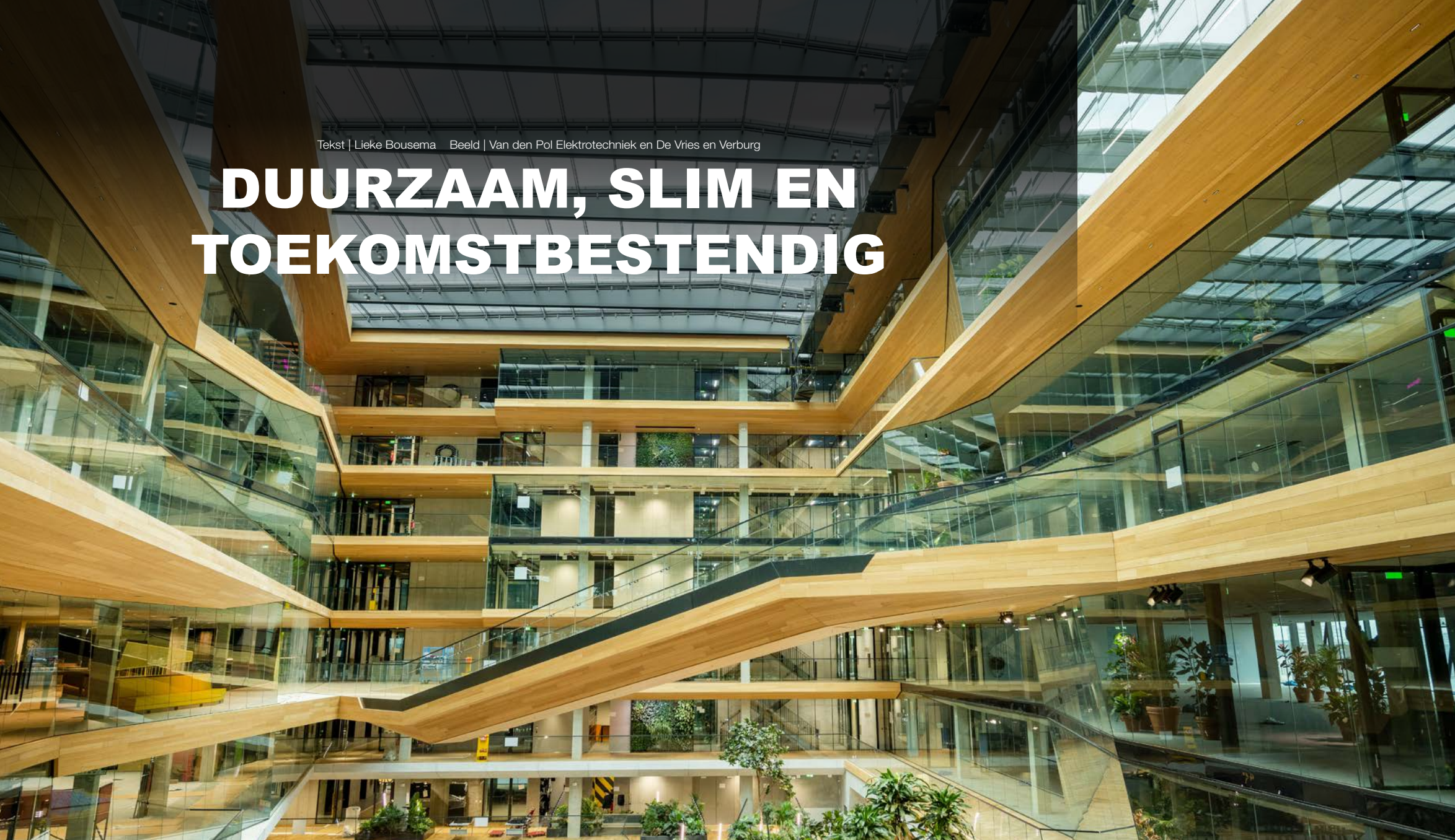
Het nieuwe hoofdkantoor van Booking.com is door Van den Pol Elektrotechniek voorzien van 1.065 zonnepanelen, ruim 9.000 led-verlichtingsarmaturen en een uitgebreid pakket slimme sensoren.
