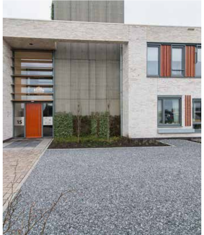
Alle buitenmuren en een deel van de binnenwanden zijn prefab voorbereid.
