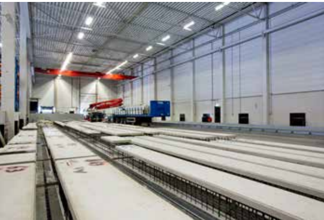
Van Berlo prefab betonfabriek Veghel.
