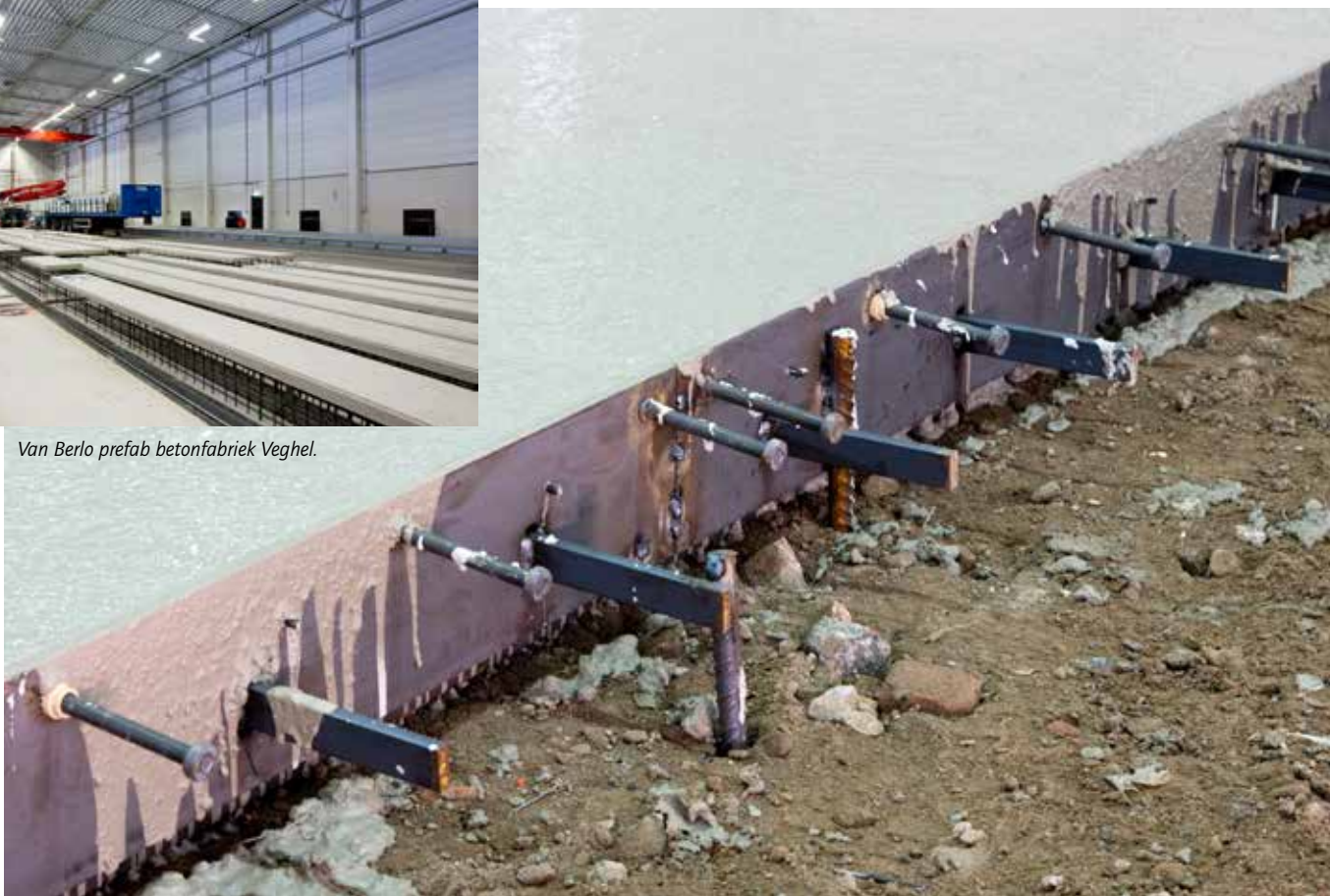
Super vlakke betonvloer.
