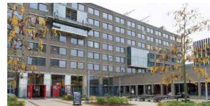
Het laag- en hoogbouwdeel van Sanders Building, met de gevelboxen als eyecatcher.
