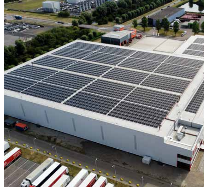
Op het dak zijn 4.200 zonnepanelen geïnstalleerd en de omgeving wordt rijkelijk bekleed met groen.
