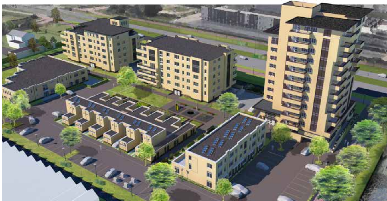
Het project De Linden bestaat uit appartementengebouwen, patio-woningen, maisonnettes en zorgstudio's.
