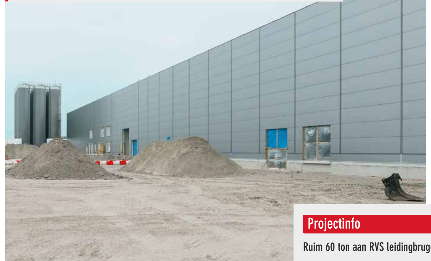
De buiten- en binnenwanden van de nieuwbouw worden uitgevoerd met sandwichpanelen.
