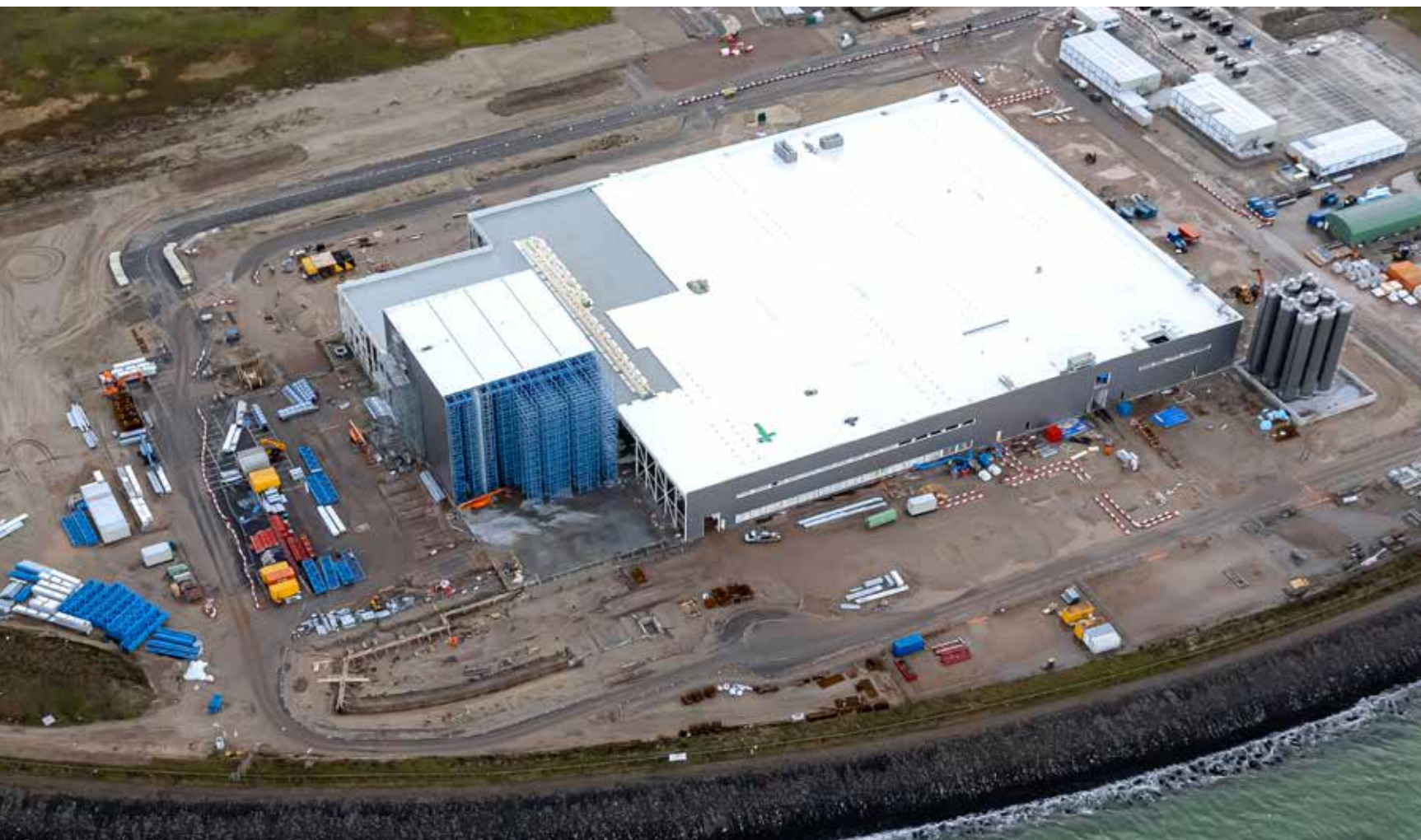
De staalconstructie bestaat voor bijna 80% uit duurzame en recyclebare materialen.
