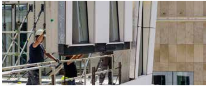
Prefab gevelelementen: een betonnen buitenblad en zandstenen afwerkingslaag inclusief isolatiesysteem en beglaasde kozijnen.
