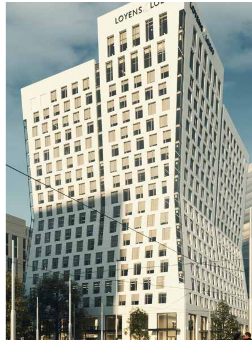
In Hourglass had Klimaat-service Holland B.V. niet alleen te maken met een hoge BREEAM-NL-ambitie ('Excellent'), maar ook met drie zeer verschillende hoofdgebruikers.
