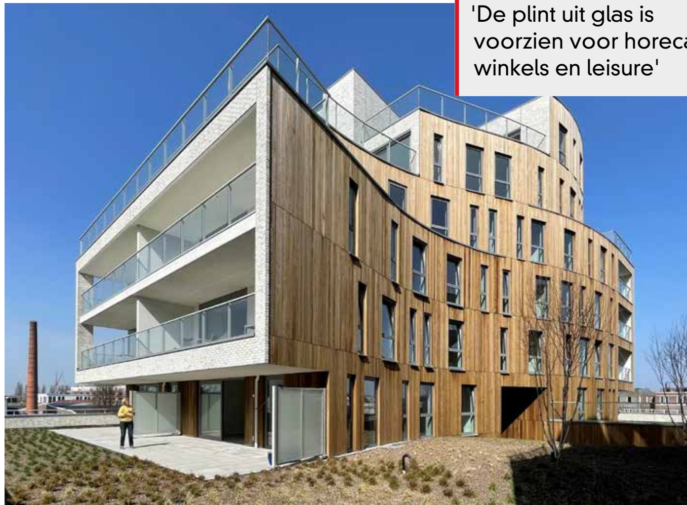
De golvende binnengevel aan de kant van de binnenruimte is bekleed met hout.
