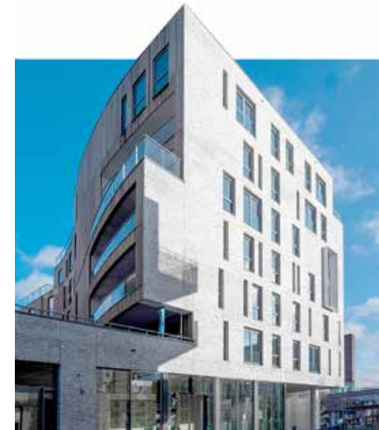
Terwijl de plint uit glas bestaat, is de buitenkant van de gevel opgetrokken in lichtgrijze stenen. (Beeld: Aad Trompert)
