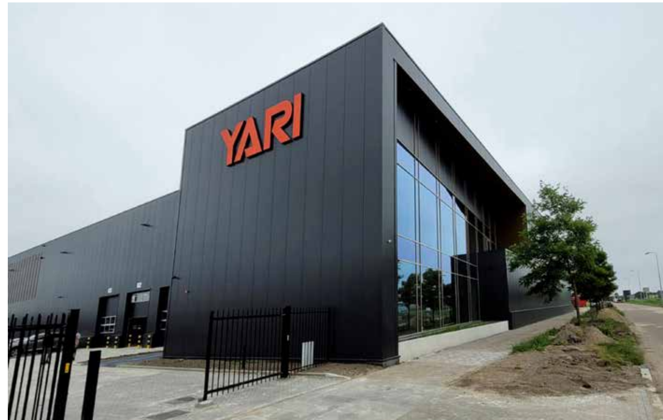
Het architectonische accent wordt gevormd door een inspringende en afgeschuinde vliesgevel aan het kantoorgedeelte.
