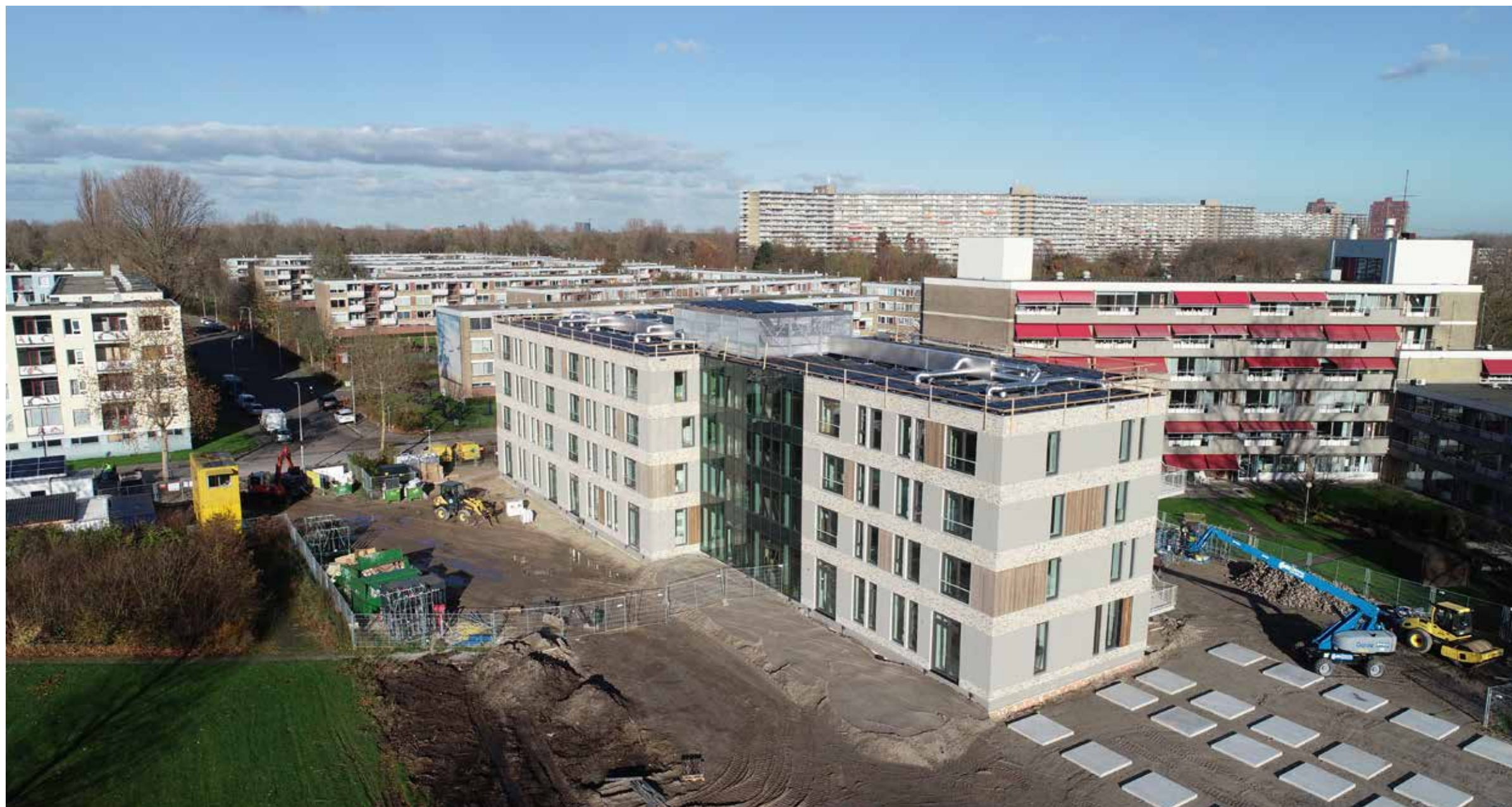
Het zorggebouw nadert de opleveringsdatum
