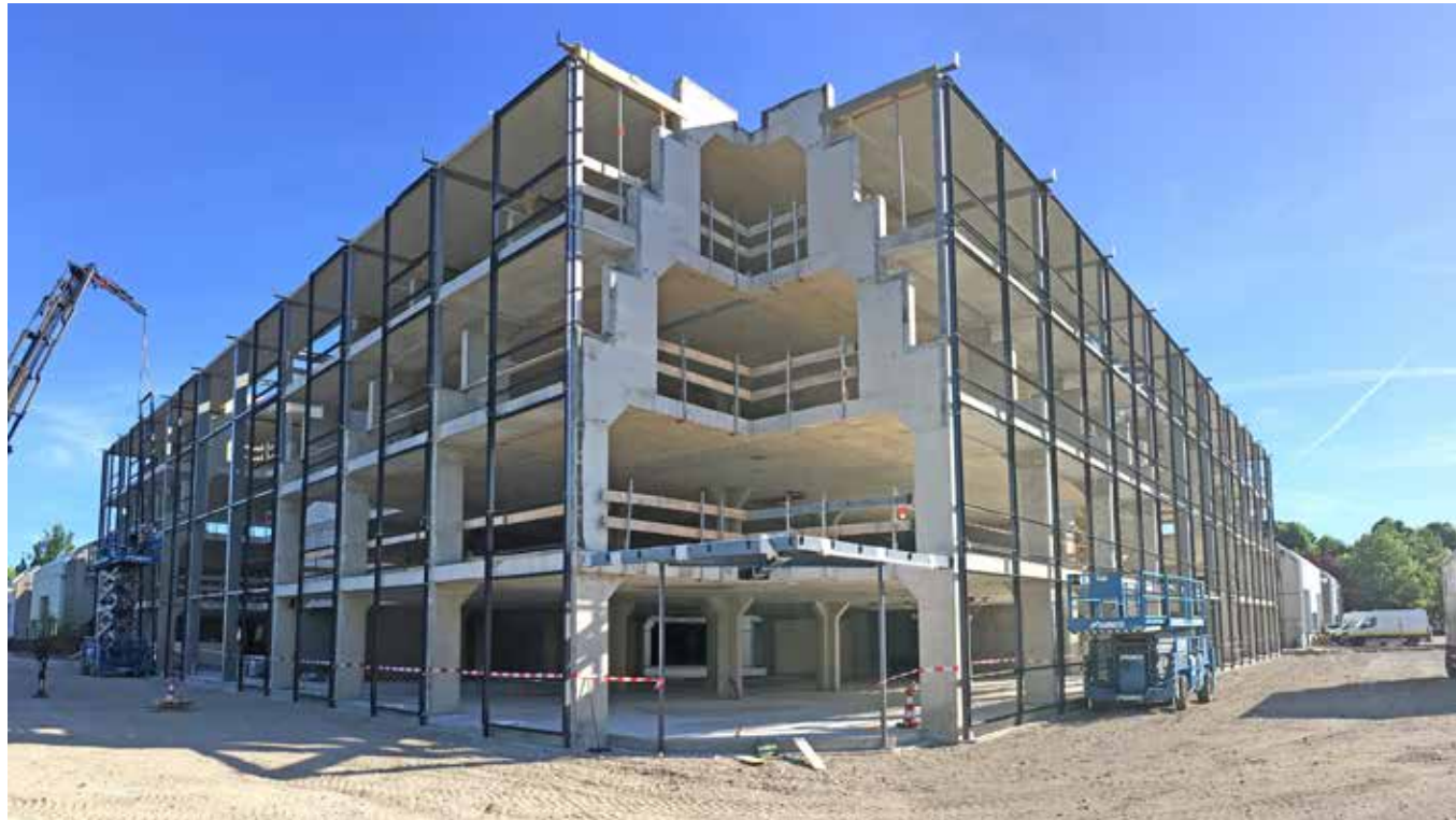
De gevel was eerst getrap en wordt nu recht.
