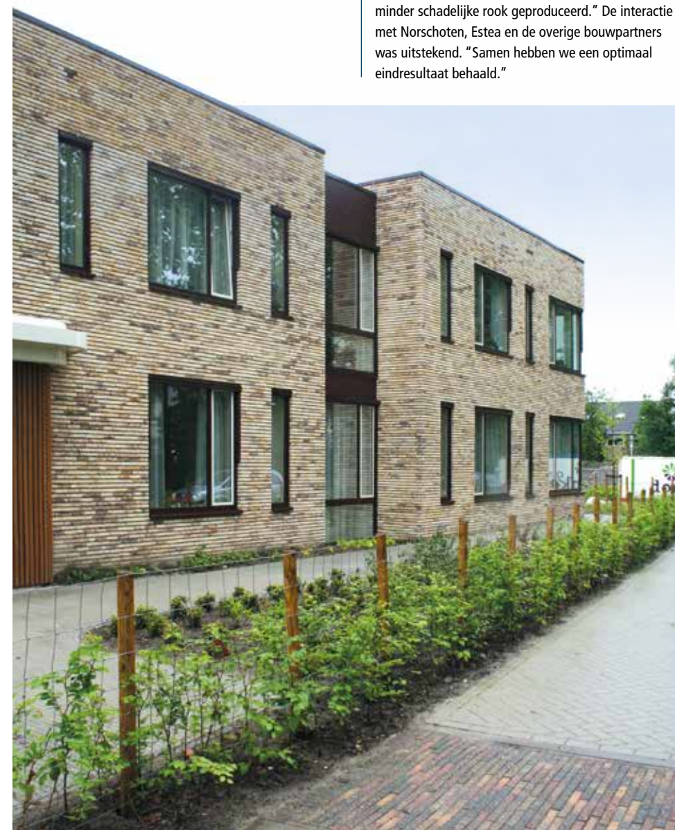
Nieuwbouw aan de Drostendijk.
